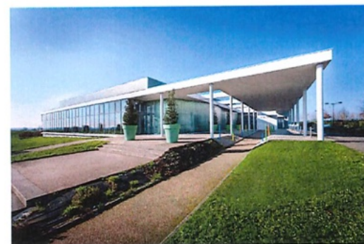
La piscine vue de dehors
